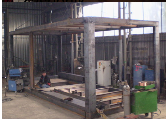
▣ Konštrukcia ťtrkového zásobníka
