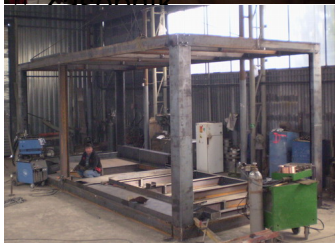
▣ Konštrukcia ťtrkového zásobníka
